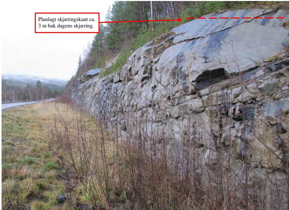
Foto 19: Profil ~18750, usikret skjæring fra sidetak langs dagens trasée.
