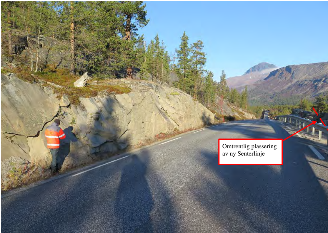
Foto 11: Profil ~7700, Oversiktsbilde tatt mot Viskisbru, planlagt veg går til høyre om eksisterende E6, ved Viskis bru har den samme linjeføring som E6.
