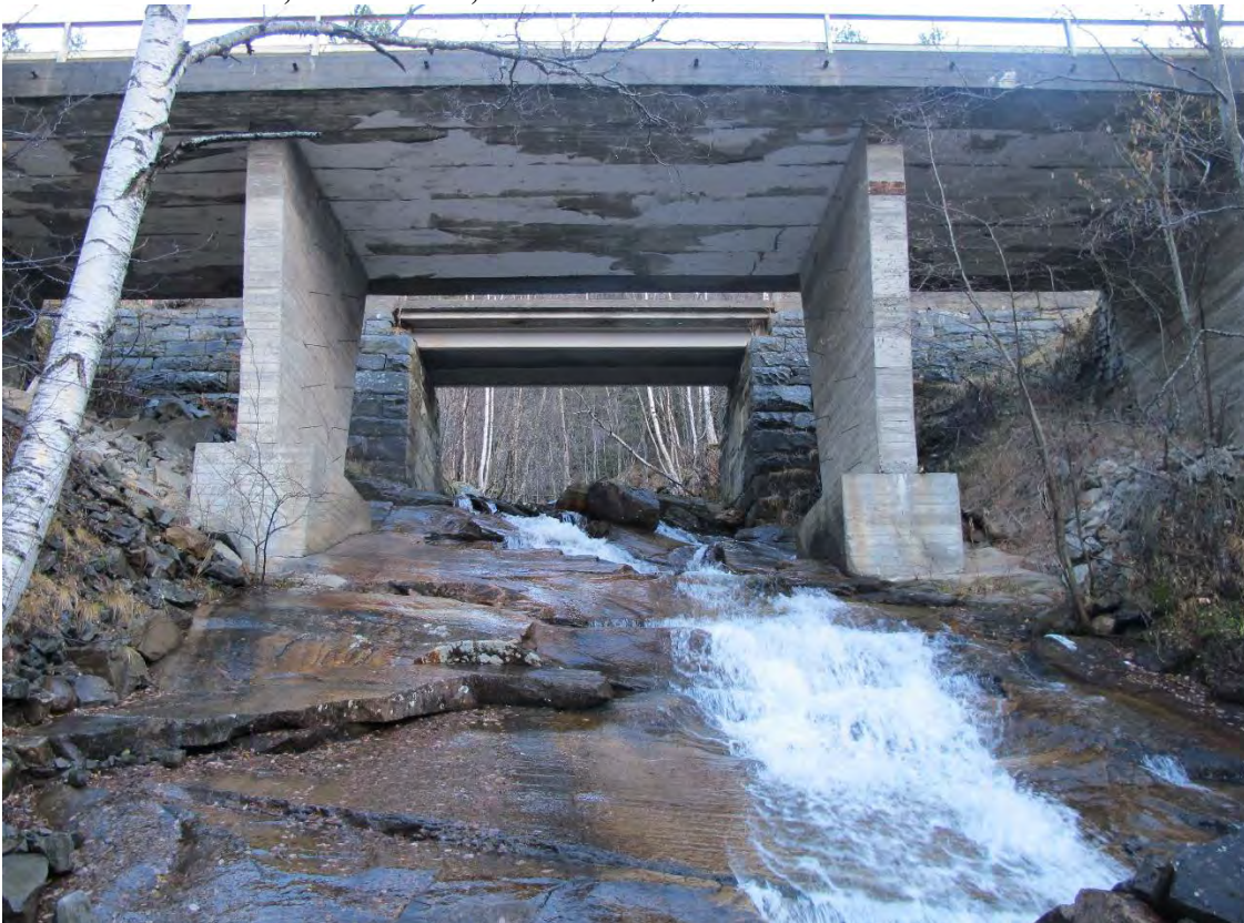
Foto 16: Profil ~17700, Trollnesågabru, dagens bru nærmest i foto. Fundamentert på fast fjell, bergmassen er lite oppsprukken.
