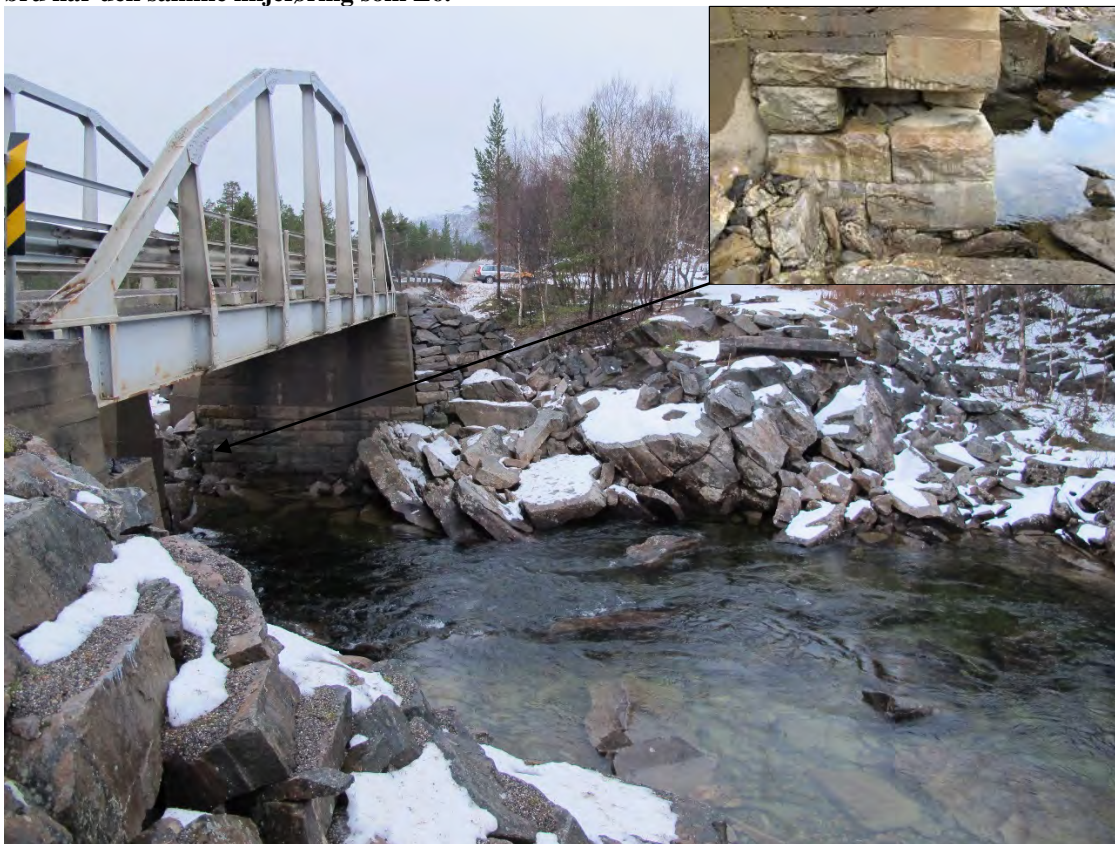
Foto 12: Profil ~8250, Viskisbru, foto tatt mot nord, fundamenteringen får utstå store påkjenninger fra isen.
