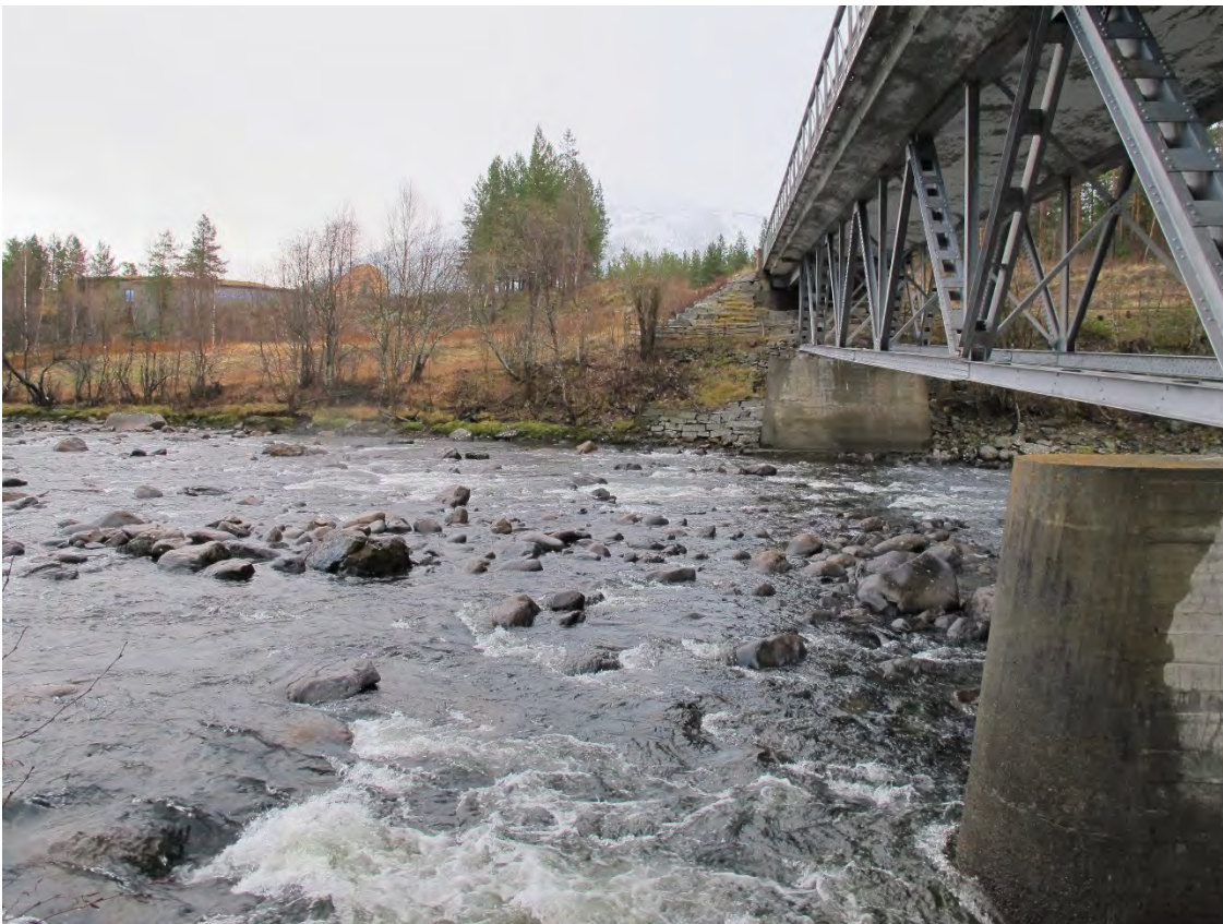
Foto 14: Profil ~15300, Bru over Junkerdalselva, foto tatt mot nord.
