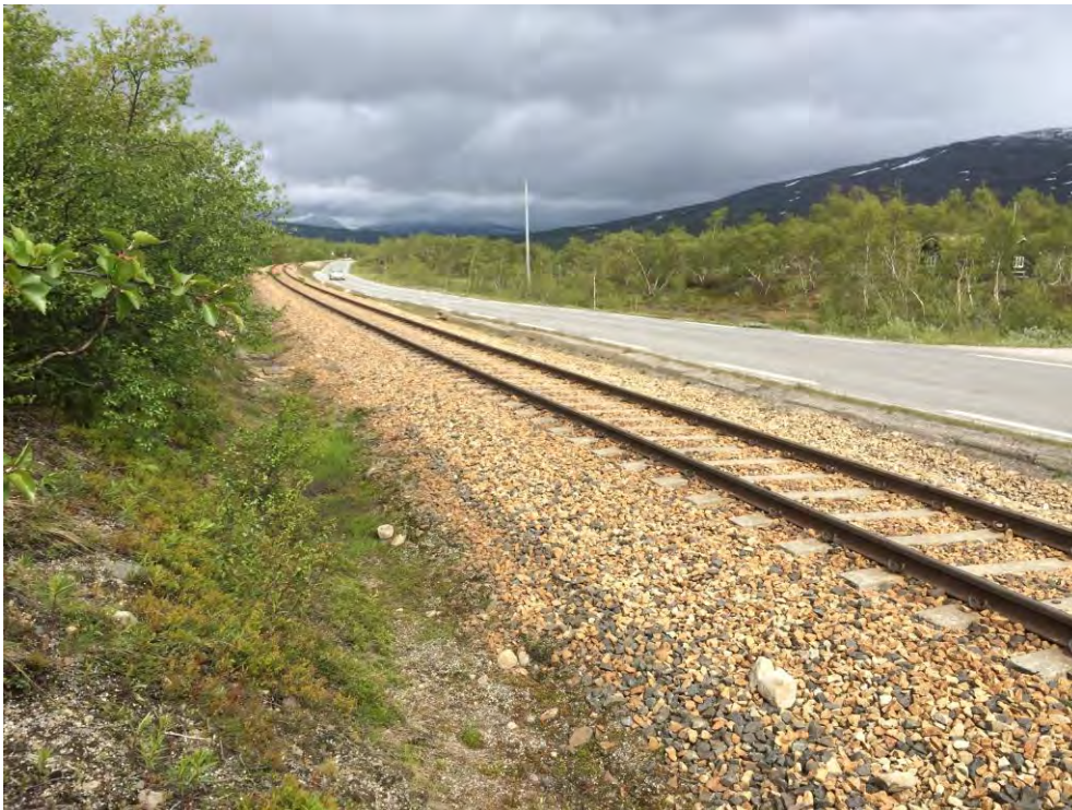
Fig 4-12. Ved Rausteinbekken (1550m). Jernbanen løper parallelt med E6. Foto M. Selnes, Norconsult.
