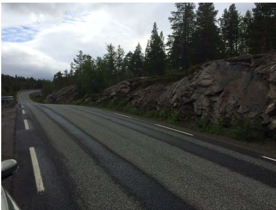
Fig 4-13: Nord for Lønsdal (5650m). Flyttlei krysser E6. Omlegging med utsprenging av ny trase. Se også fig 3-18. Foto M. Selnes, Norconsult.
