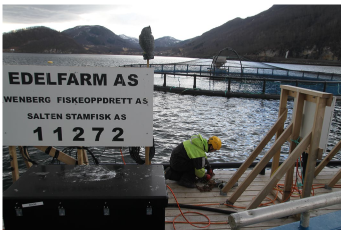
Montering av lyttestasjon på oppdrettslokalitet. Foto: Sindre Eldøy
