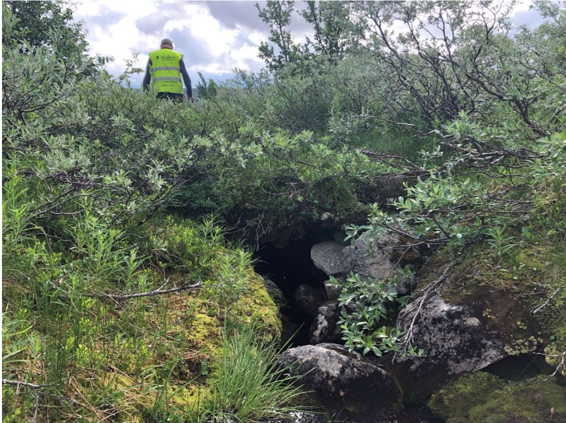
Bilde av brua inne i OT-leiren, tatt mot øst. Foto datert juli 2021.
