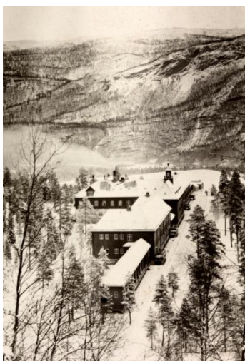
Figur 4-25. Vensmoen med liggehallene i forkant og kurstien «Karl Johan» som går langs hele lengden av fasaden mot parken. (Kilde: Digitalt museum.no)
